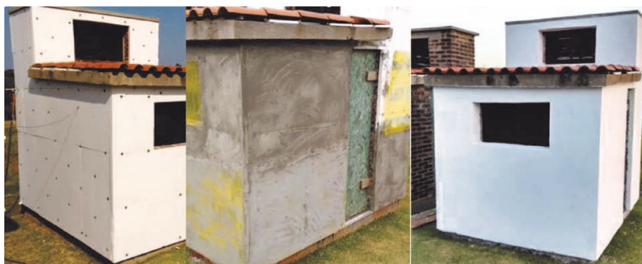
Figura 3 – Aplicação do sistema Etics (Aplicação EPS; aplicação tela em fibra de vidro; reboco e pintura final).
