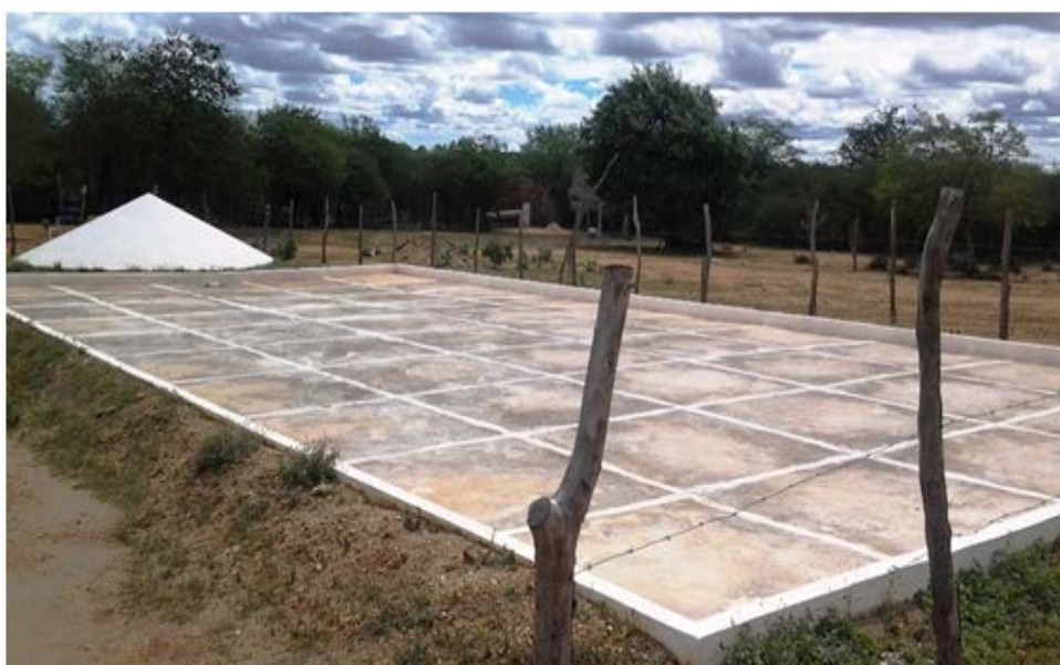
Figura 3 – Imagem de uma cisterna-calçadão do município de Tenente Laurentino no Rio Grande do Norte.
