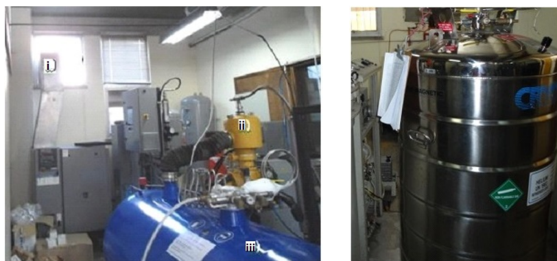
Figura 2: (a) à esquerda: equipamento que produz Nitrogênio: i) parte do equipamento que faz a sucção do gás; ii) local onde há a separação do nitrogênio do ar; iii) local onde nitrogênio gasoso é transformado em líquido. Fonte: foto Laboratório Criogenia. (b) à direita: tambores onde são armazenados o Hélio e o Nitrogênio. Fonte: foto Laboratório Criogenia.
