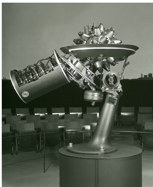
Figura 3: Primeiro projetor planetário em Jena, Alemanha, 1923. (ZEISS, 2023)
