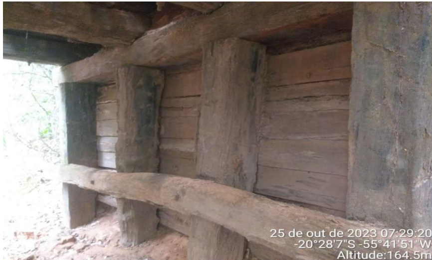
Figura 5. Imagem tirada embaixo da ponte lado direito.
