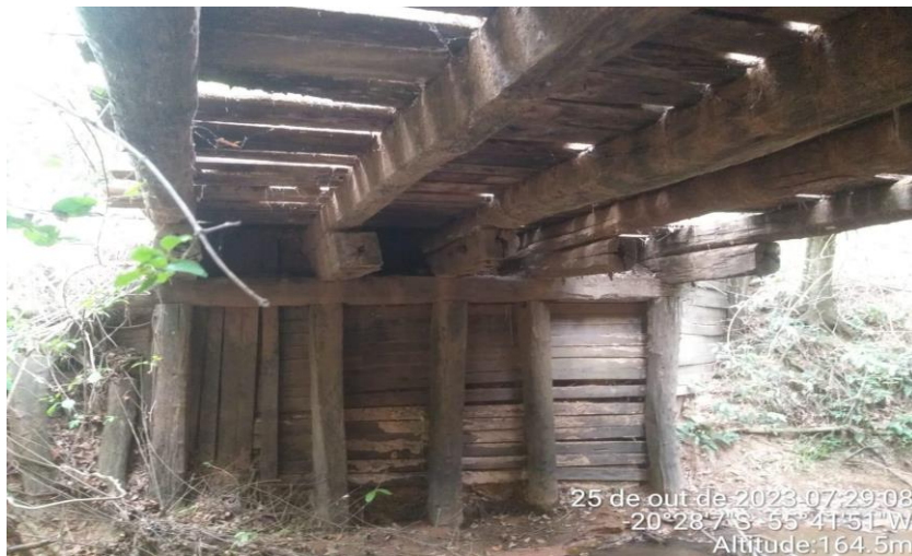
Figura 4. Imagem tirada embaixo da ponte lado esquerdo.
