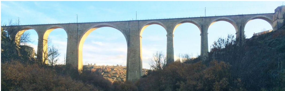
Figura 1. Ponte do Côa.
