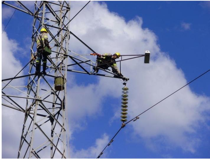
**Figura 9. Instalação do acelerômetro e sistema de registro digital do ângulo da cadeia.**
