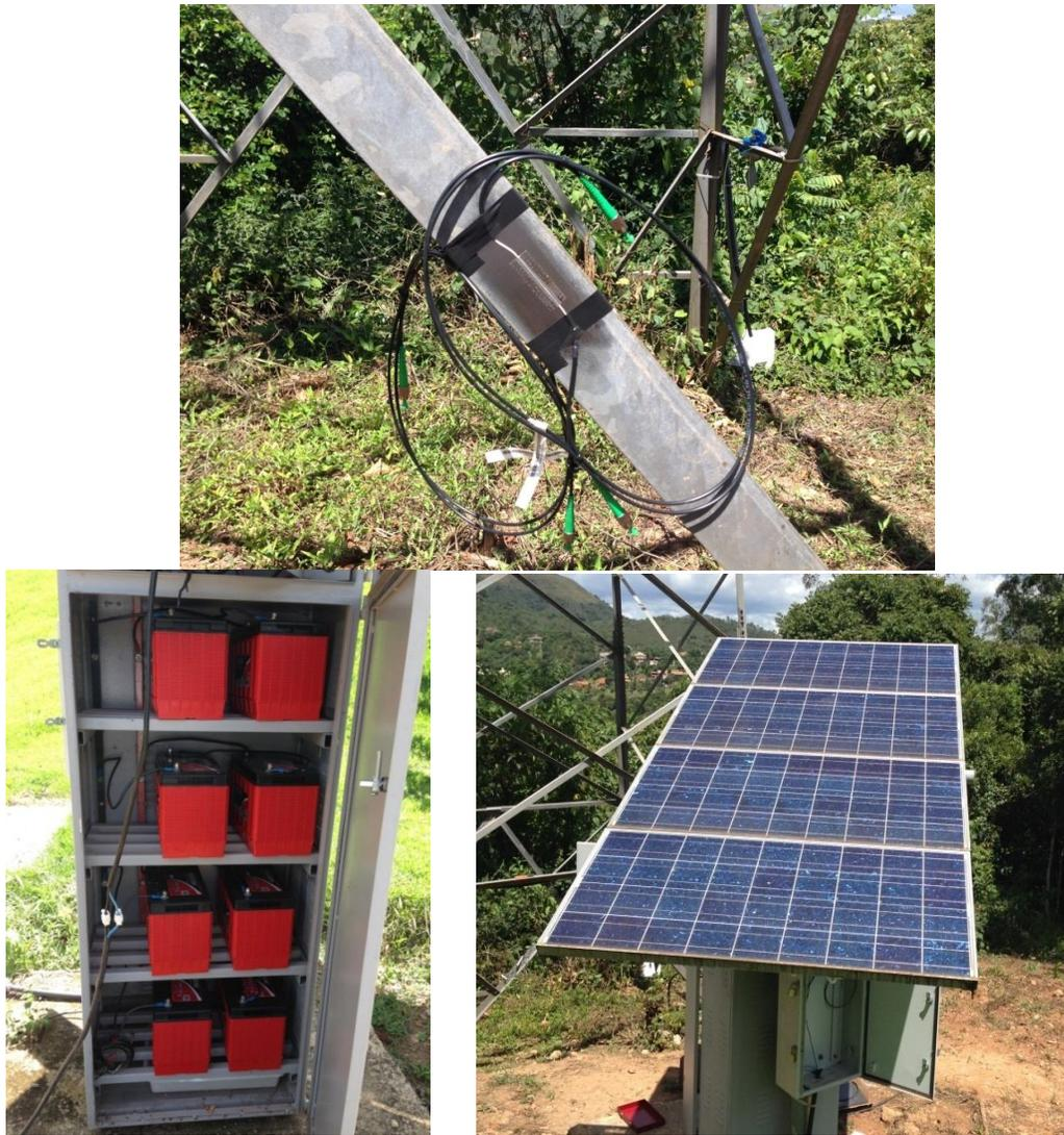
Figura 11. Sensor óptico instalado no elemento estrutural e conjunto de alimentação do sistema.
