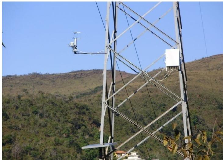
**Figura 10. Monitoramento de dados climatológicos: sistema instalado na estrutura 138 kV.**
