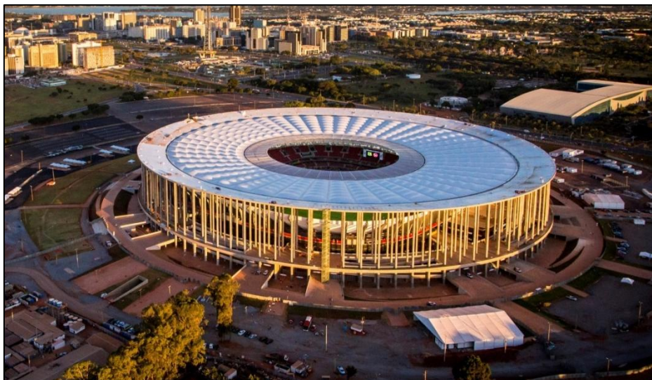
Figura 1 – Vista do Estádio Nacional de Brasília.
