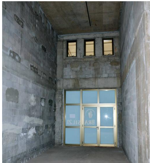
Figura 03. Local antes da intervenção.
