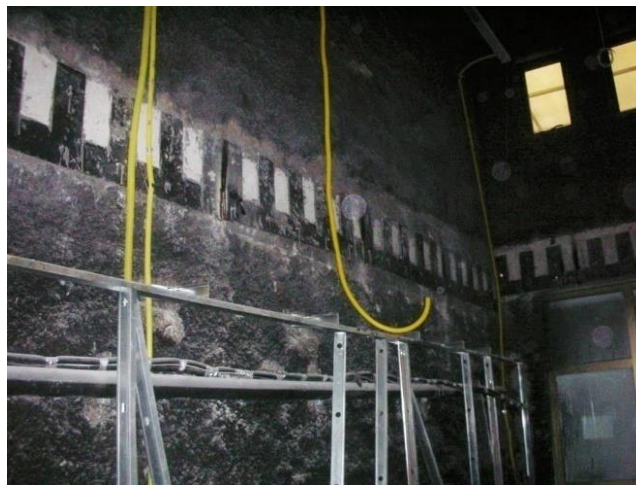
Figura 6. Foto da viga reforçada com chapas metálicas.
