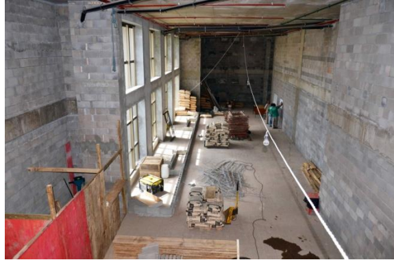
Figura 02. Local antes da intervenção.
