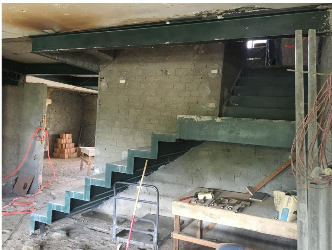
**Figura 20. Escada em chapas dobradas com patamar em perfil caixão**
