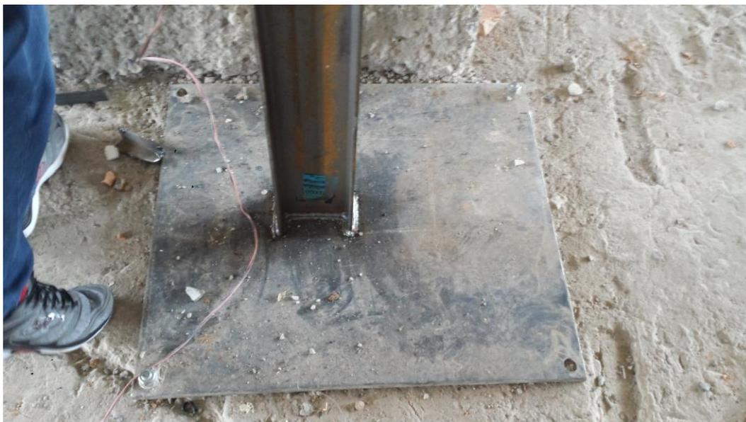
**Figura 19. Detalhe base do pilar durante montagem**
