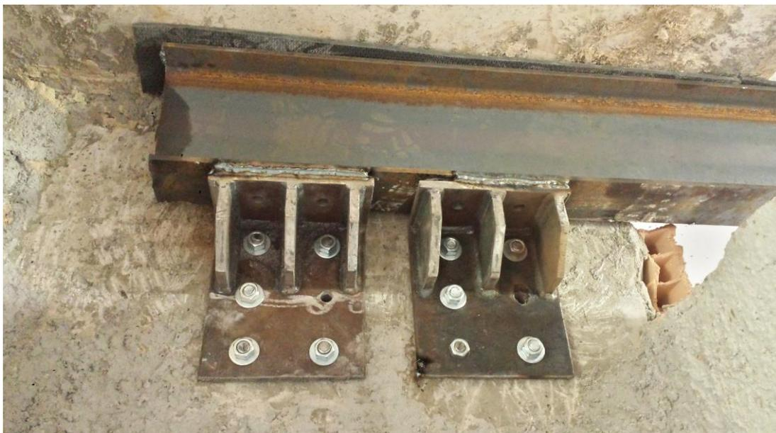
**Figura 15. Detalhe apoio das vigas durante montagem**
