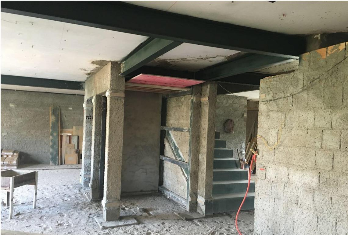
**Figura 17. Estrutura de pilares para apoio do elevador**
