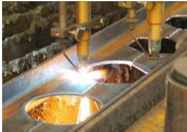
Figura 6. Fabricação não convencional de vigas celulares (Fonte: Sonck, 2014)
