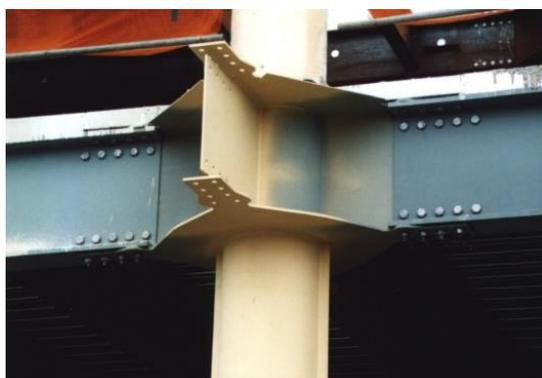
**Figura 1. Diafragma externo, aeroporto de Auckland, Nova Zelândia (Disponível em: <[www.atlastube.com](http://www.atlastube.com)>. Acesso em: 17 out. 2013.)**
