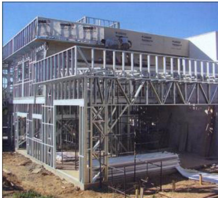
Figura 1. Residência em Light Steel Framing (CBCA, 2006)
