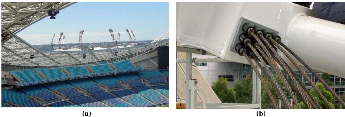
Figura 4. Reconstrução Estádio Olímpico de Sydney (PTIA, 2007): a) Estruturas da treliça protendida e b) Cabos ancorados na treliça
