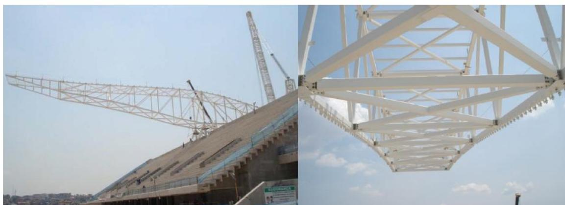
**Figura 1. Primeiro conjunto de treliças da montagem da cobertura do Estádio Itaquerão**
