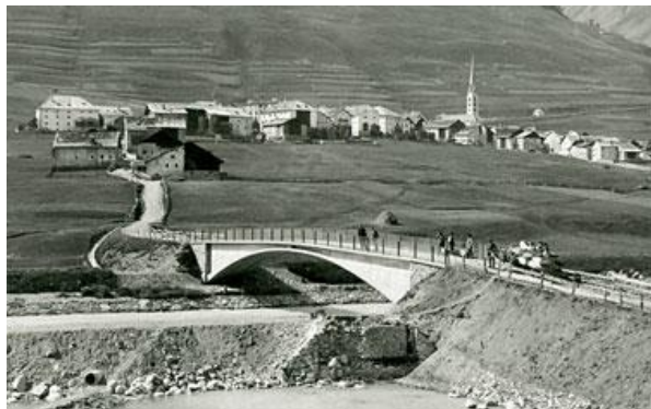
Figura 8- Ponte Zuoz sobre o rio Inn
