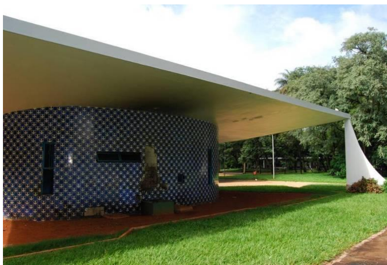
Figura 10 - Vista posterior da Igrejinha – não se nota a presença de vigas na cobertura. Foto do autor.
