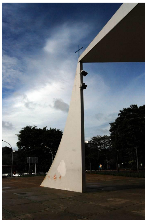
Figura 25. Pilar Frontal da Igreja Nossa Senhora de Fátima. Foto do autor.
