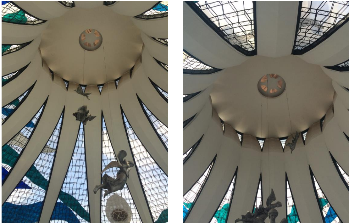
Figuras 2 e 3 – Placa circular anular da Catedral com os 3 anjos atirantados. Fonte: Os autores (2016)
