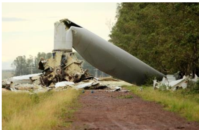
Figura 1. Colapso de torres eólicas no Rio Grande do Sul (Portal Energia, 2015)
