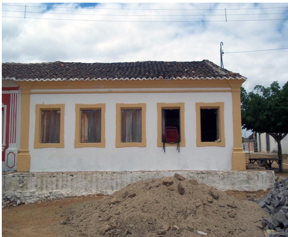
Figura 3. Casa das 12 janelas, Fachada voltada para a lateral da igreja, antes da intervenção 2013-2014 – Foto de Luiz Freire
