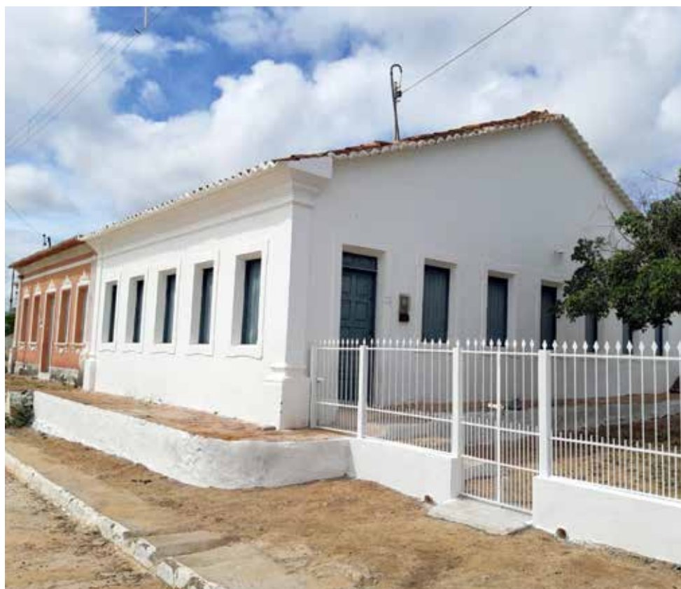
Figura 6. Casa das 12 janelas depois de recuperada, 2018. Foto de Luiz Freire.
