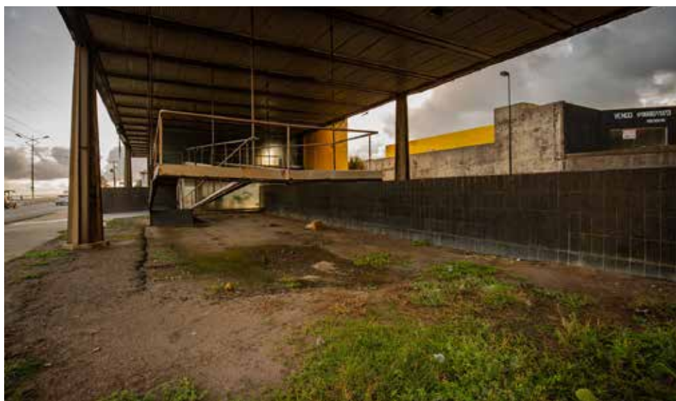
Imagem 7. Pilotis e vestígios da rampa atirantada TCU/AL, 2017. Autor: Eurípedes Neto. Fonte: https://euripedesneto.myportfolio.com/maceio
