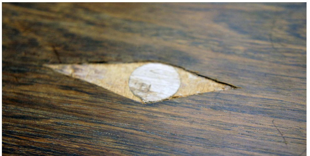
Figura 3: Intervenção - preenchimento do furo central, colagem e calafetação do tampo. Fonte: IFB
