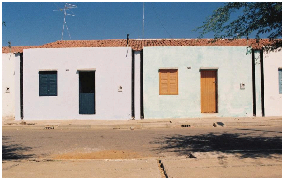
Imagem 11. Habitações operárias em Caraíba (BA), arquitetura em correspondência ao savoir-faire vernacular local (antigo ou novo?). Fonte: < https://www.archdaily.com.br/br/768316/classicos-da-arquitetura-caraiba-joaquim-guedes/557878cde58eced628000017-classicos-da-arquitetura-caraiba-joaquim-guedes-foto?next_project=no >
