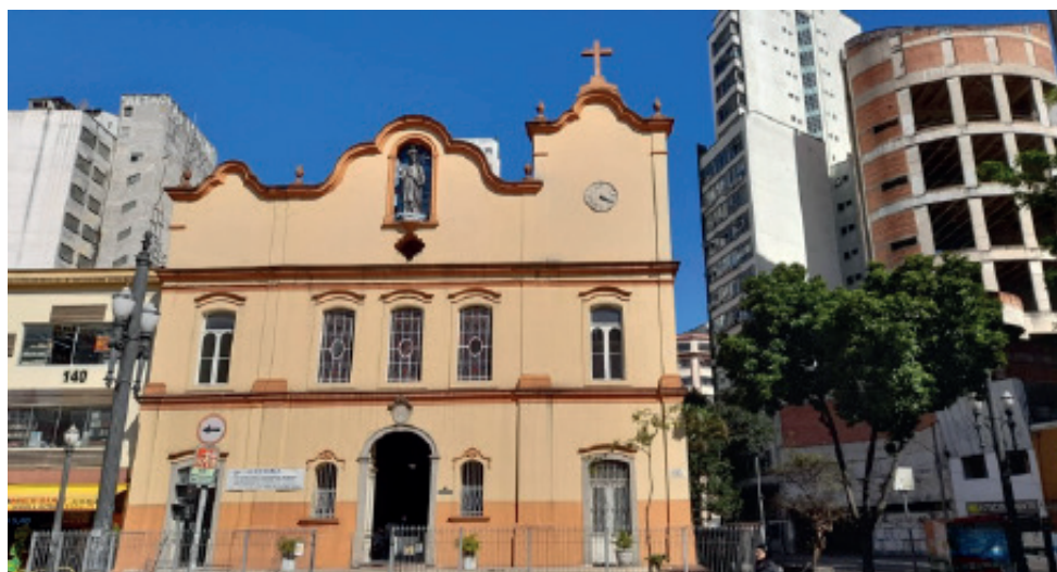
Imagem 1. Igreja de São Gonçalo, São Paulo, SP. Fonte: Bruna de Assis, 2022
