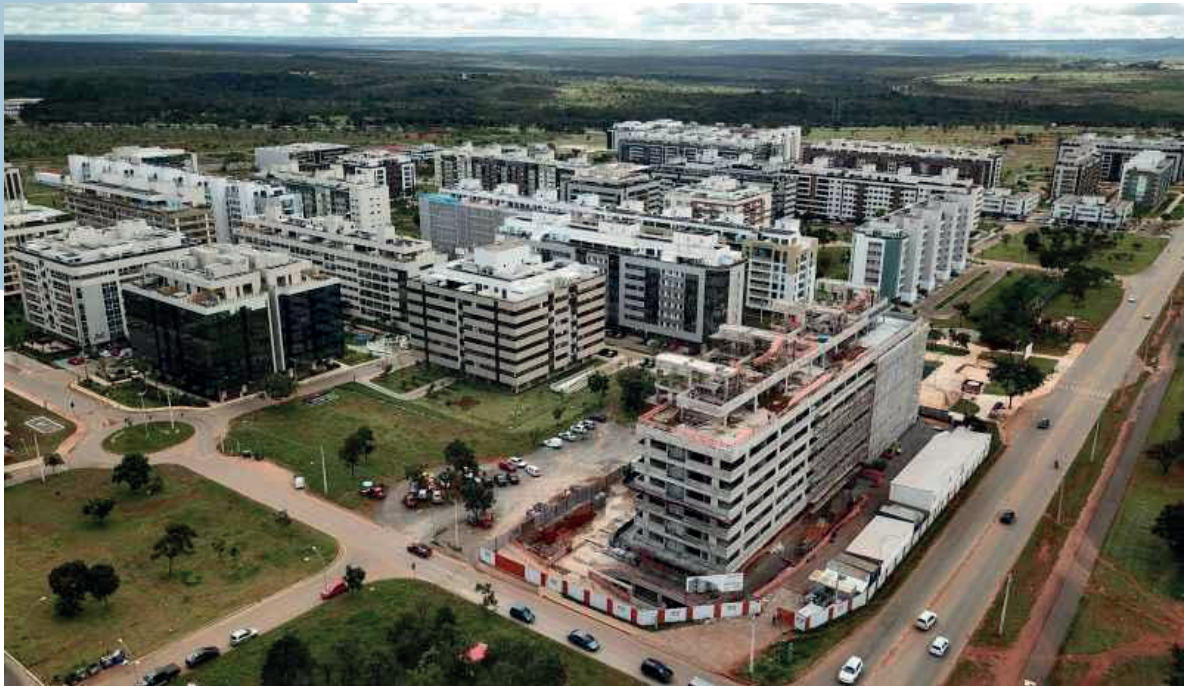
Figura 2 – Visão superior do Setor Sudoeste após a construção*
