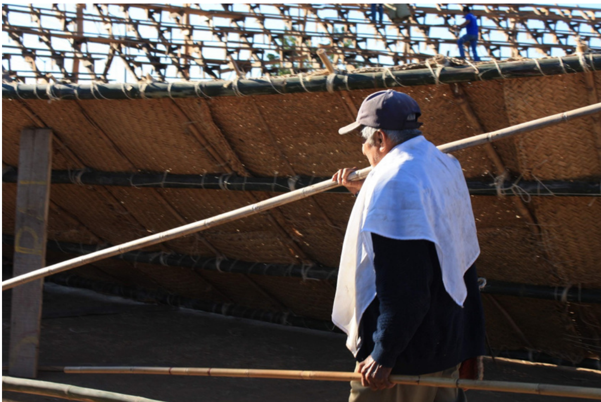
Figura 2. Tabladero construyendo La Petartera
