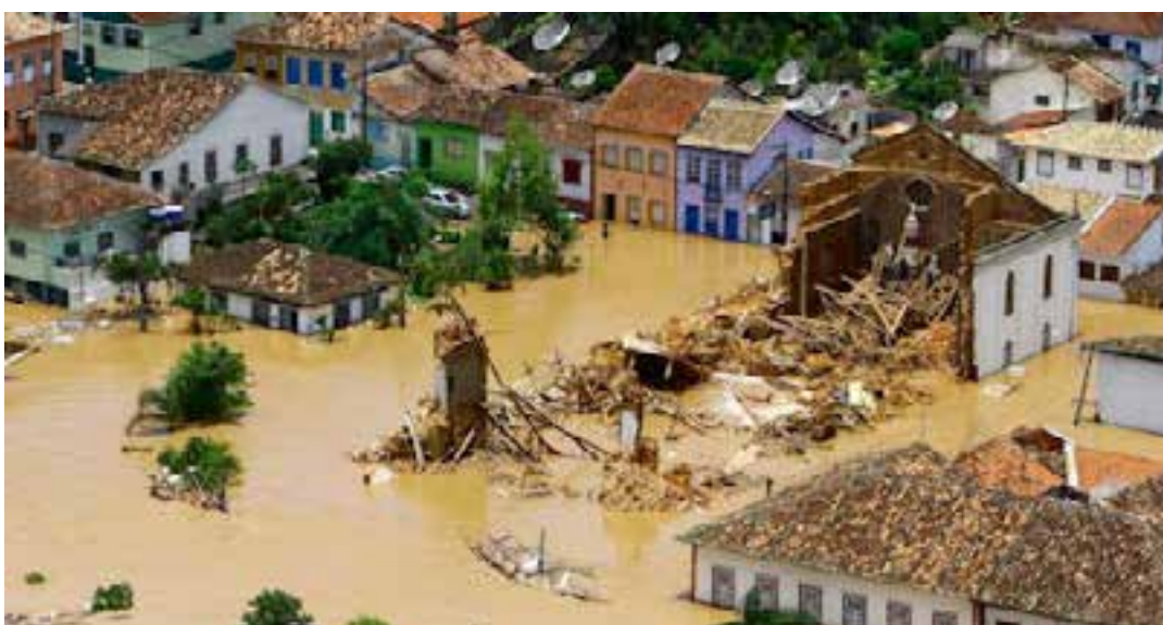
Figura 4: Vista do centro histórico inundado e ao centro, a matriz de São Luiz de Tolosa em ruínas.
