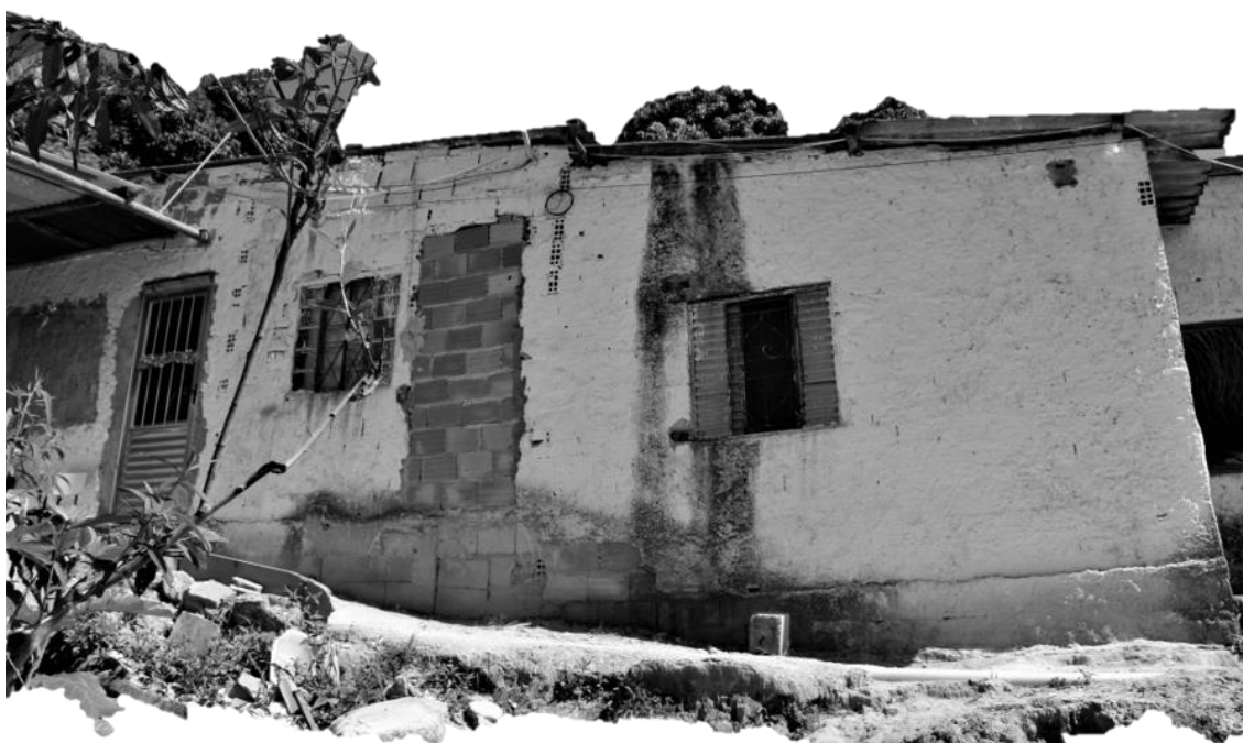
Figura 3- Colagem: “Fachada principal da casa de Mametu e uma parte do Barracão”
