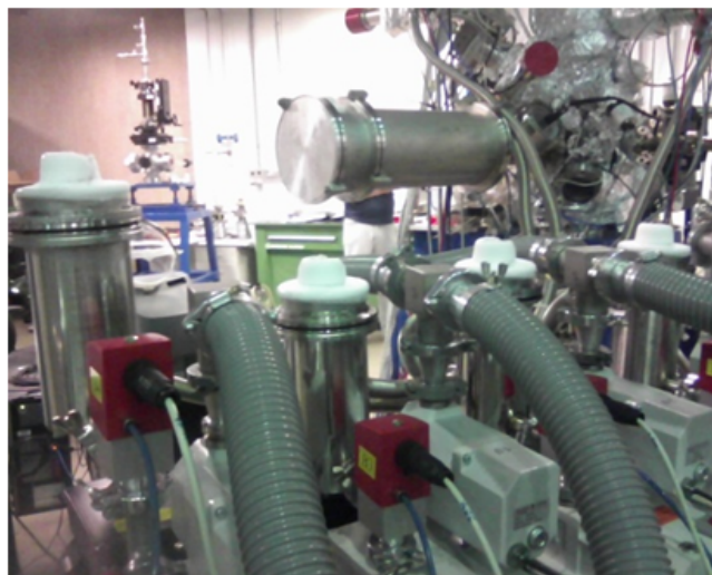
Figura 3: Reservatórios de nitrogênio líquido.
