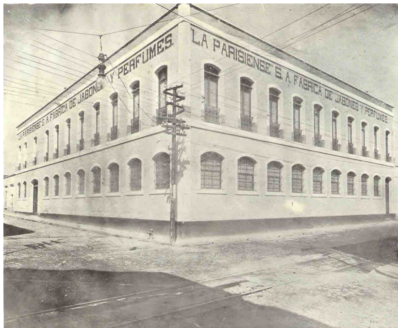
Figura 6 – La Parisiense 2, actualmente en estado de deterioro
