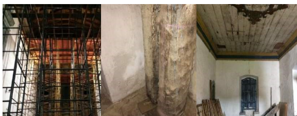
Figura 8 – Interior da Igreja Nossa Senhora da Lapa
