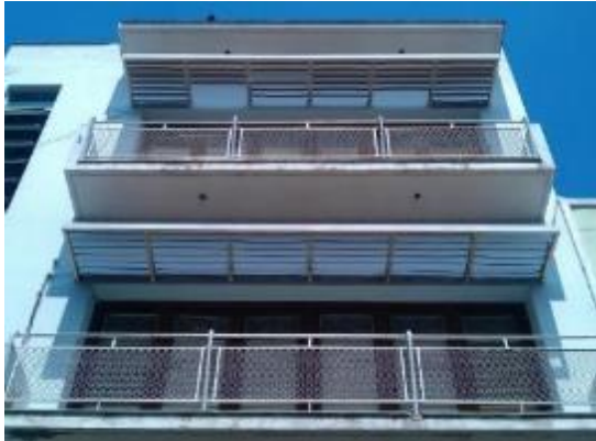
Figura 7 – Elementos de control ambiental en fachadas
