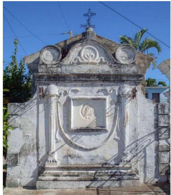
Figura 3 – Vista de construcciones en el primer tramo del Cementerio
