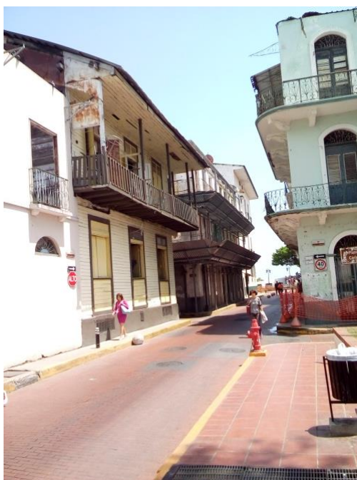
Figura 3 – Viviendas dilapidadas en el Casco Antiguo de Panamá
