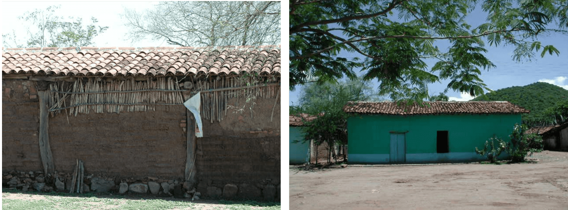
Figura 4 Imágenes de vivienda tradicional de bajareque y adobe.
