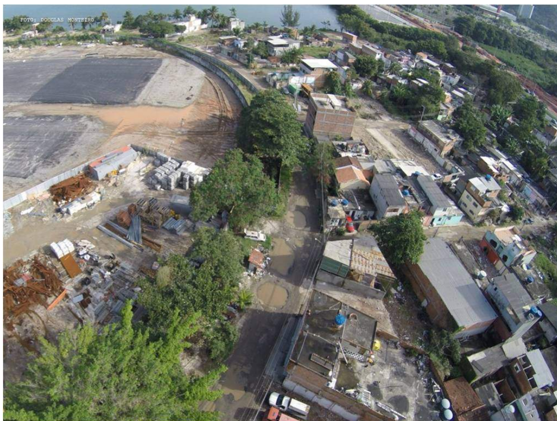
Figura 2 – Foto aérea da Vila Autódromo com as obras do Parque Olímpico em curso, Rio de Janeiro, Brasil
