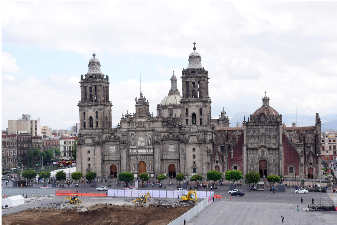
Figura 5 – Catedral Metropolitana de Ciudad de México, sometida a importantes trabajos de restauración, 2001
