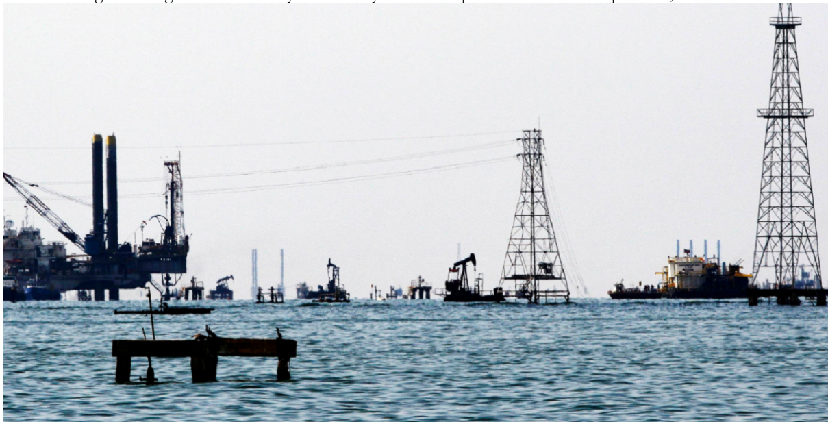
Figura 1. Lago de Maracaibo y sus torres y balancines para la extracción de petróleo, Venezuela
