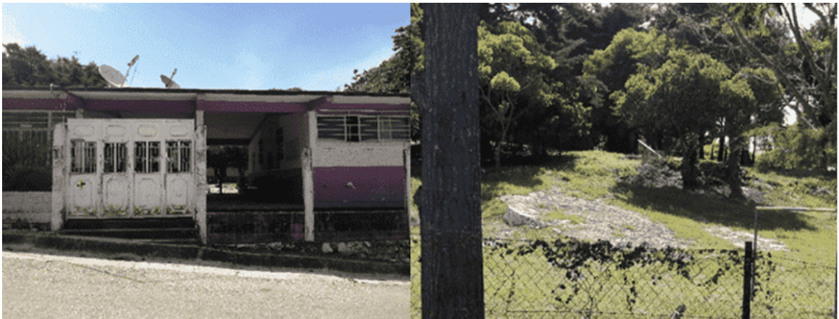
Figura 17 – Vista de la fachada principal de la escuela y algunos vestigios de cimientos dentro de ella
