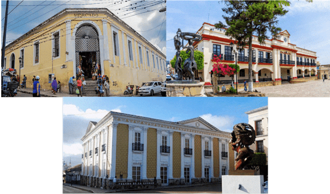
Figura 24 – Estado actual del Mercado Municipal, Palacio Municipal y el Teatro de la Ciudad
