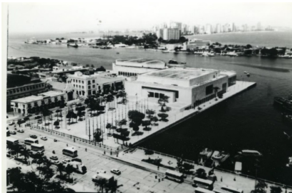
Figura 4 – Centro de convenciones (1990)
