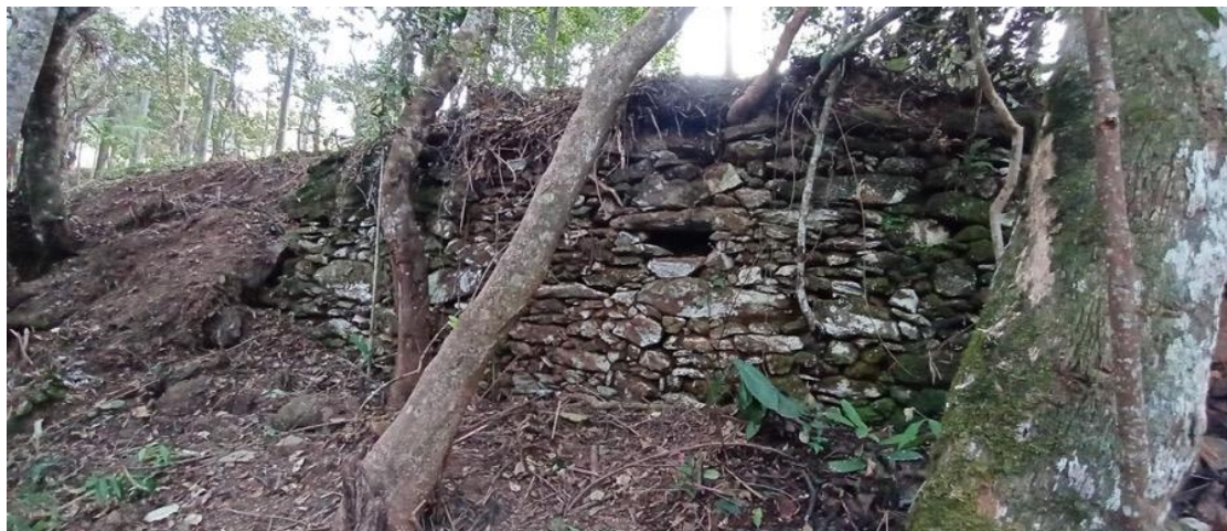
Figura 3 - Muro de contenção e rede de drenagem nas proximidades da Rua Padre Marcelino Braga, em Itatiaia. Verifica-se claramente o leito da antiga estrada em meio à mata e trechos apoiados pelos muros de pedras.
