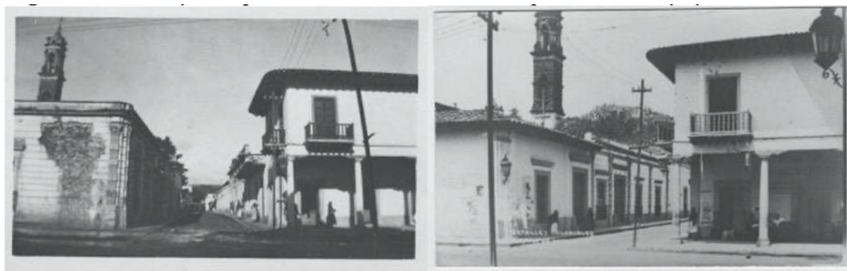
Figura 8 – El antes y el después de las obras urbanas en la esquina de 5 de mayo y Lázaro Cárdenas
