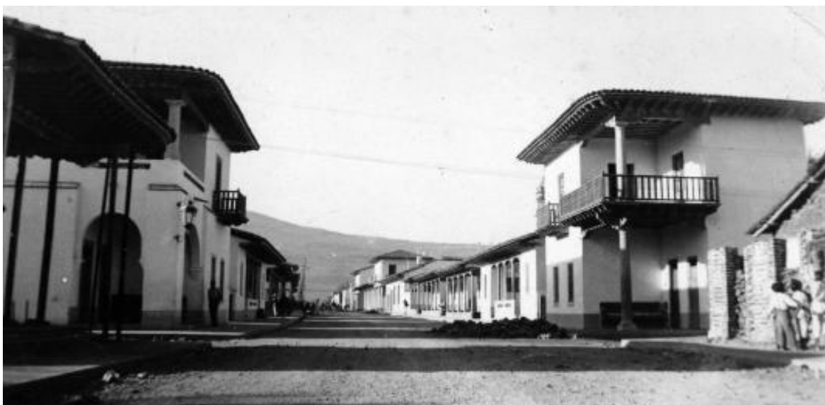
Figura 7 – La Calle Profesor Fajardo después de las obras urbanas.
