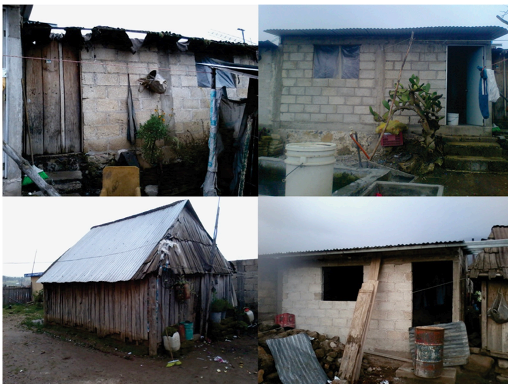
Figura 6– Vivienda modalidad 2, anterior e inconclusa posterior al programa, La Toma Ayahualulco
