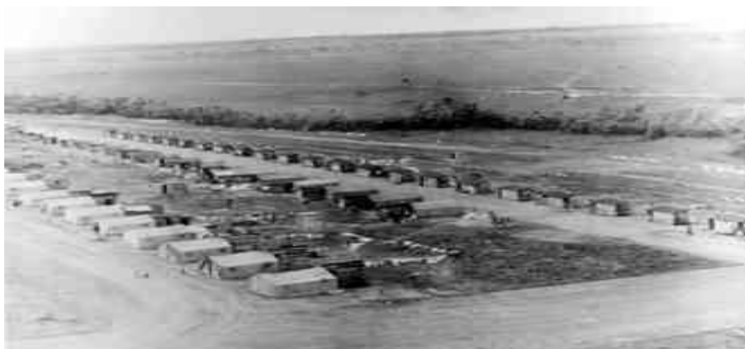
Figura 1 – Primeiros acampamentos construídos na Candangolândia pela Novacap
