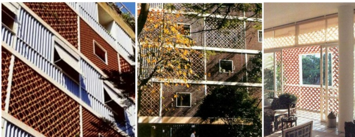
Figura 3 –El cobogó en el edificio de apartamentos de Parque Guinle, Brasil. Lucio Costa (1947)
