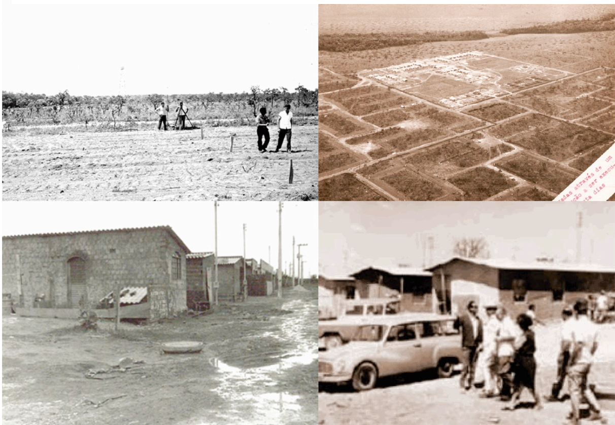
Figura 3 – Construção de habitações em regime de mutirão no Guará.
