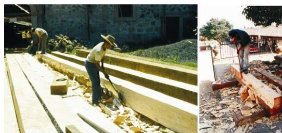
Figura 11 – Ilustraciones de artesanos realizando la escuadría de grandes vigas para la construcción
