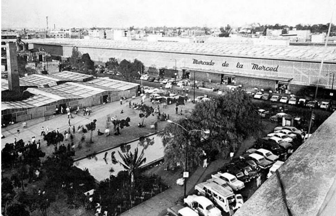
Figura 1 – Nave Mayor del Mercado de La Merced, en la década de 1960.
