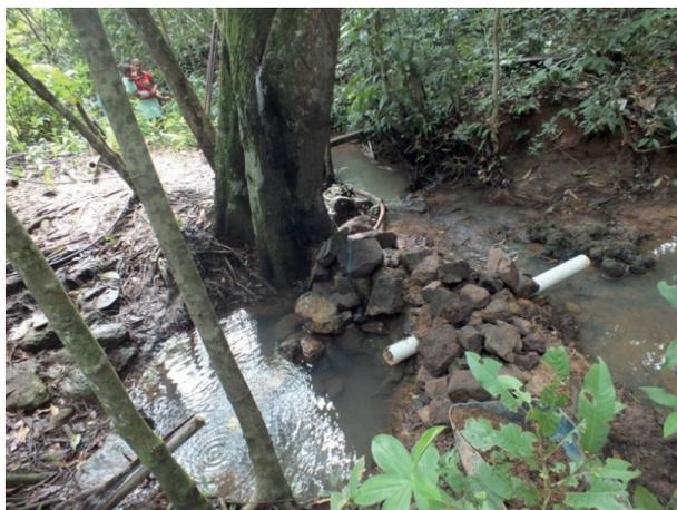
Figura 6 - Reservatório de captação. Acervo Núcleo Extensionista Rondon IFPR, Campus Palmas.
