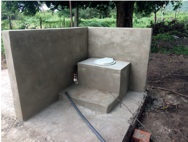
Figura 6: Etapa de reboco e acabamento do revestimento finalizada. Fonte: Autora.
