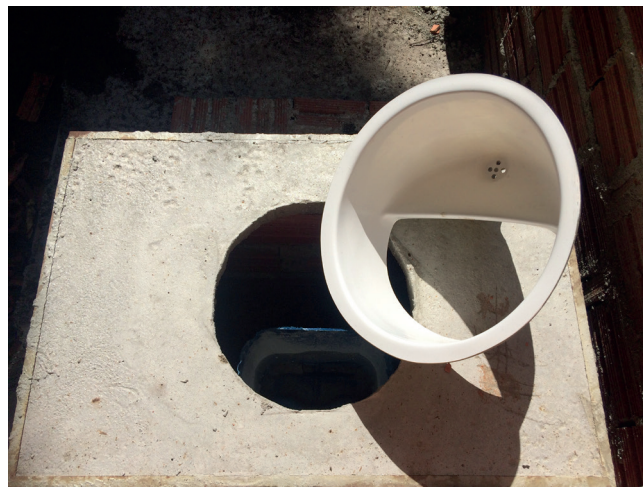
Figura 5: Detalhe da parte superior do assento e do segregados de urina. Fonte: Autora.
