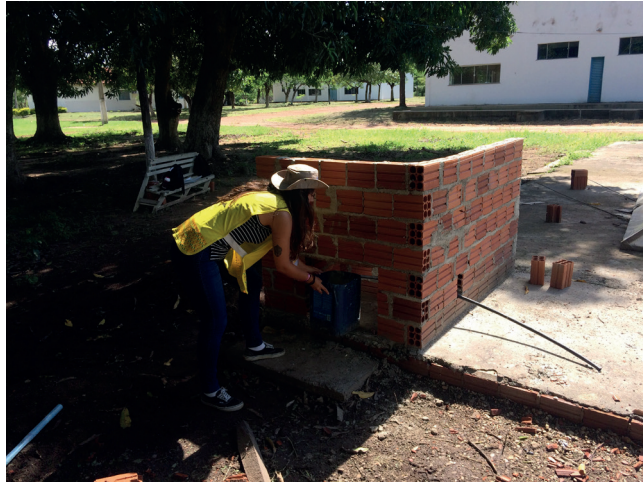
Figura 4: Abertura na parede para retirada da bombona. Fonte: Autora.
