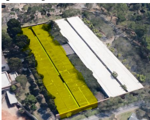
Figura 3: Imagem aérea Bloco 2 da FAE
